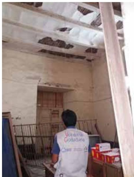
*Techos deteriorados y paredes agrietadas en el CETPRO Rosa Muro de Barragán, ubicado en el distrito de Ferreñafe, en la provincia de Ferreñafe*
