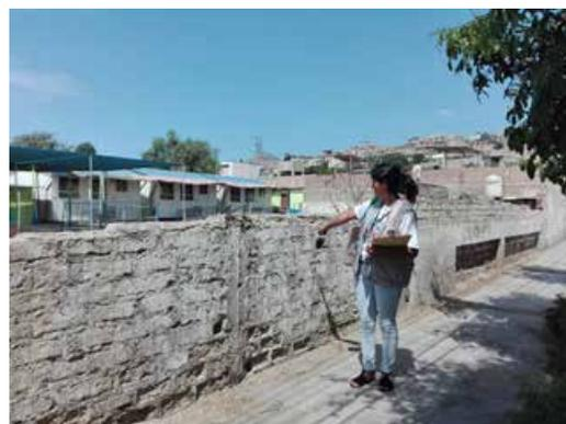
*Fotografía del cerco perimétrico que divide la avenida y el interior de la IIEE 318, ubicado en el distrito de Chimbote. Aquí se evidencia la baja altura (1.30) y la condición en que se encuentra.*
