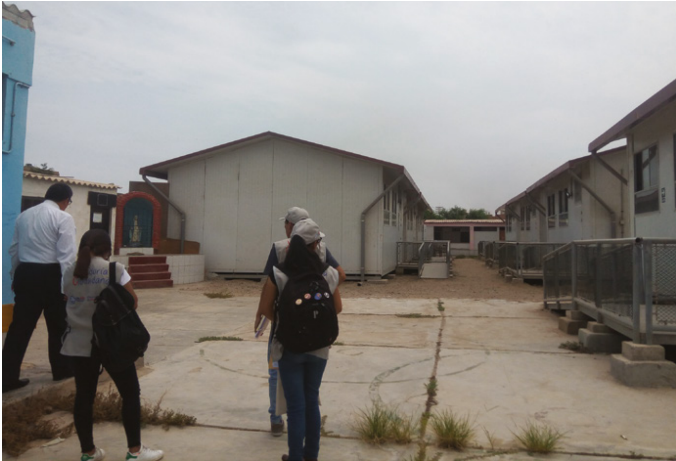
IE José Quiñones, Chiclayo. Se observa todas las aulas prefabricadas.
